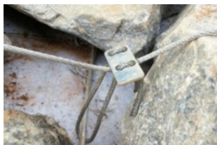
4. 하부망, 상부망 연결작업
